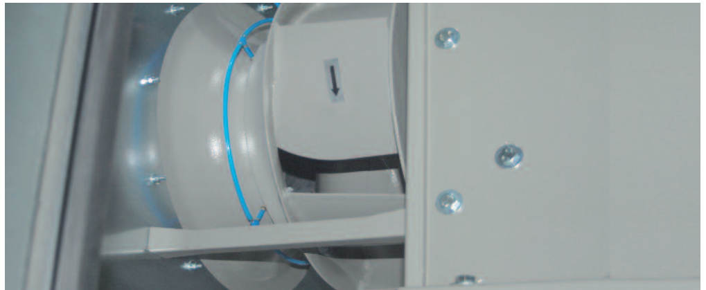
Ventilatoreinheit System ETA® mit Volumenstrom-Messaufnehmern
