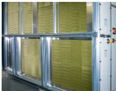
System HPWRG mit 60 000 m³/h Luftleistung
