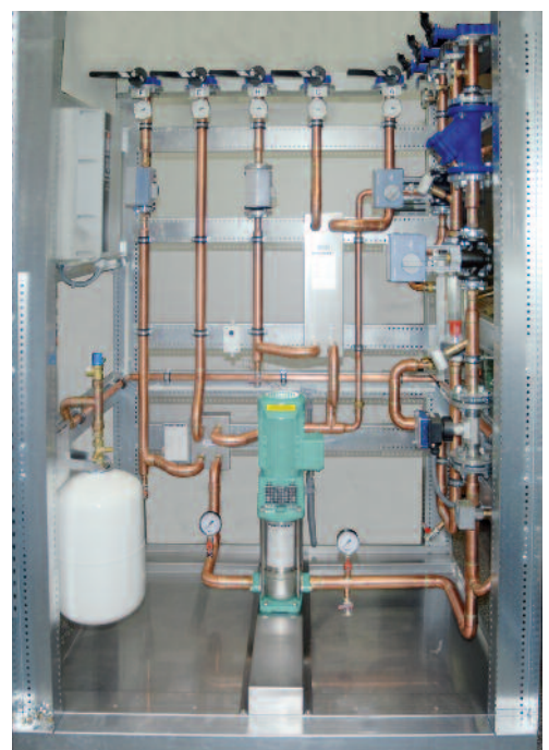
Versorgungsmodul mit kompletter Hydraulik
